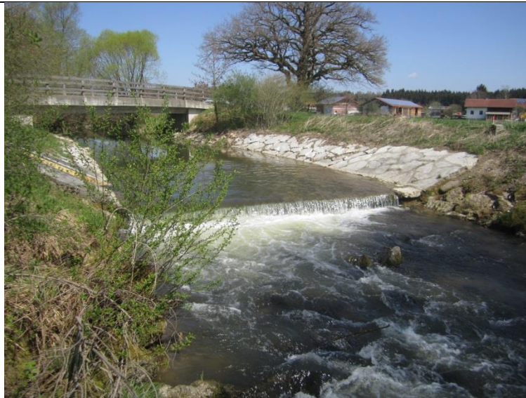
Absturz am Pegel Ammerberg, Fkm 22,500 Gemeinde Petting
